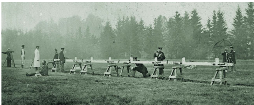
1850. aastatest pärit pilt Struve baasjoone mõõtmisest. Baasjoone mõõtmiseks tuli maastikul valida sobiv vahemik. Mõõtmisel kasutati selleks spetsiaalselt valmistatud neljast latist koosnevat süsteemi
