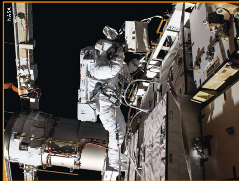
Robert Behnken vahetab ISS-i energiasüsteemi akusid
